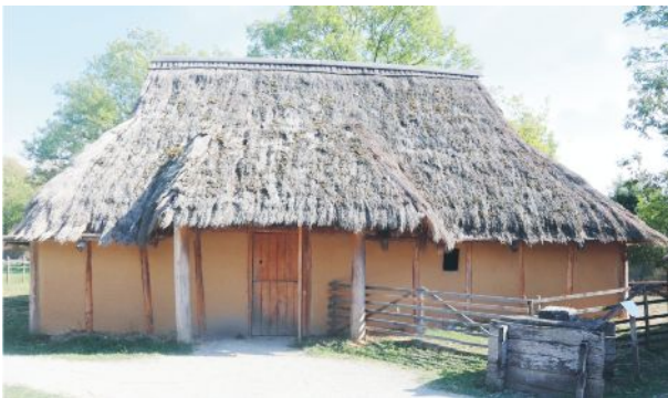
post-Romeinse hoeve te Bad Windsheim
