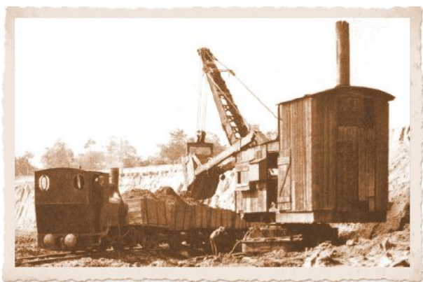
Achter in het kraanhuis staat de stoommachine
