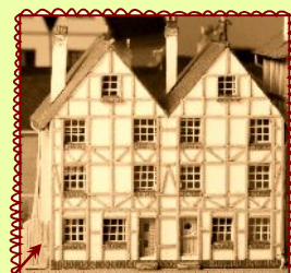
I wee arbeidershuizen aan de Hinterstrasse
